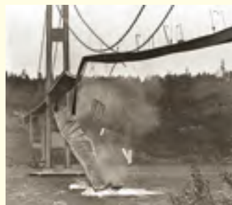
Рис. 29. Разрушенный мост через реку Такома (США)
